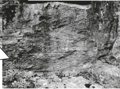
(b) Vue de détail de la base du front de taille.
